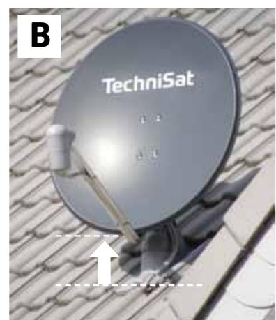
Achten Sie bei der Dachmontage darauf, dass die DigitalSat-Antenne mit genügend Abstand zum Dach montiert wird (Bild A). Befindet sich die DigitalSat-Antenne zu dicht am Dach (Bild B), kann der Empfang bei Schneefall beeinträchtigt werden.
