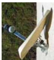
Parallele Wandmontage mit kurzer Halterung
